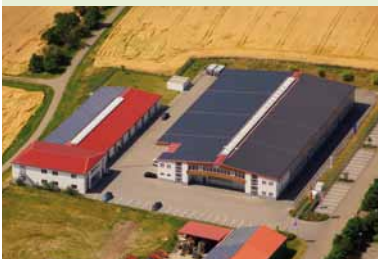
Photovoltaikanlage auf den Firmendächern
